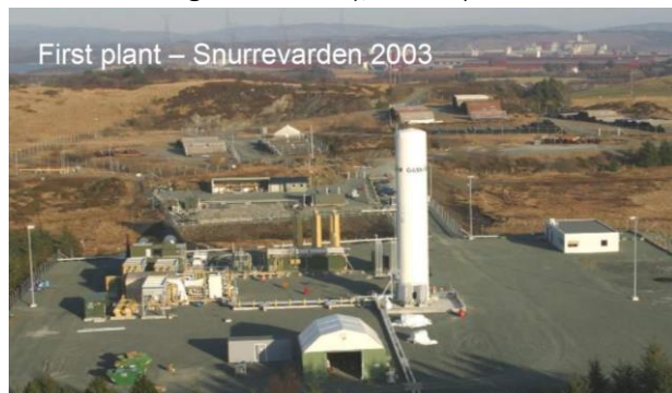
Figur 1 oversigtsbillede af LNG-Plant foto: Wärtisilä.
