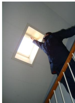
Røgudluftning skal kunne ske gennem åbenbare vinduer i facaden eller i taget. Foto: Nordjyllands Beredskab
