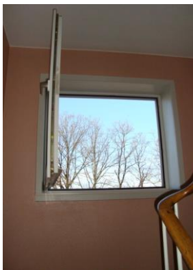
Røgudluftning skal kunne ske gennem åbenbare vinduer i facaden eller i taget. Foto: Nordjyllands Beredskab
